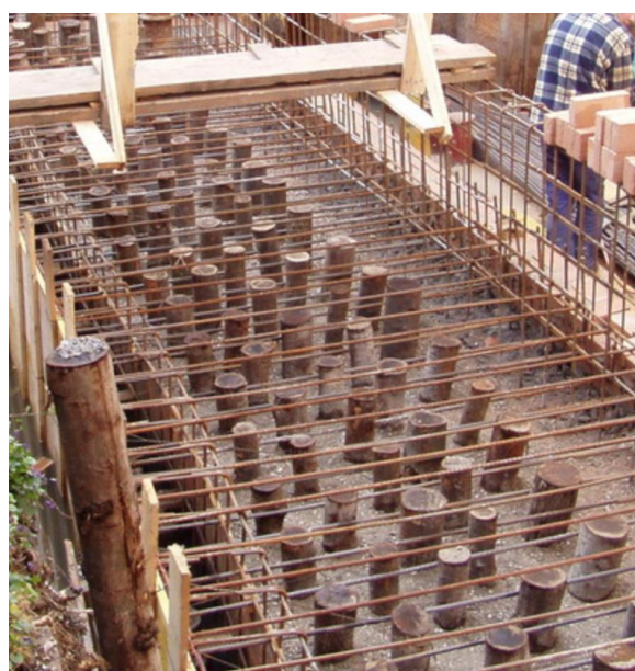
Obr. 6 Uspořádání dřevěných pilot v Benátkách – Roloff (2016)
